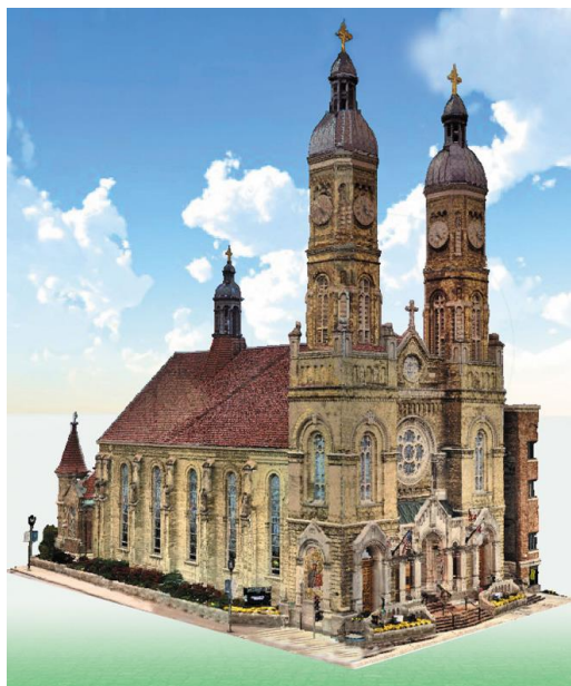
Rysunek 6.16. Model punktowy 3D dwóch ścian zewnętrznych kościoła św. Stanisława Biskupa i Męczennika.
